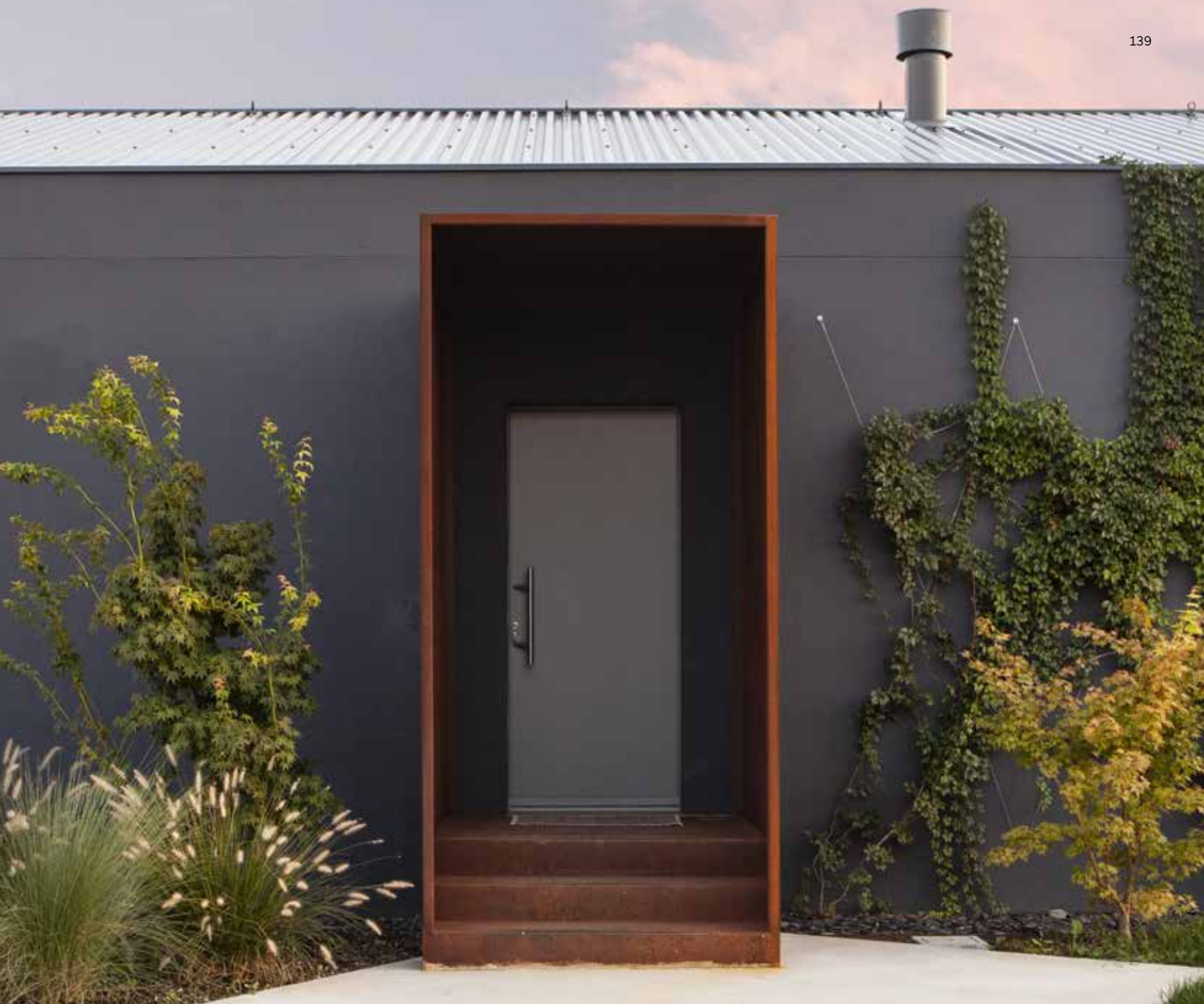
↑ The Shell PassiveHouse: la porta d'ingresso Finstral dal design sobrio ed essenziale offre un ingresso confortevole in questa casa a basso consumo energetico a Cesena.
